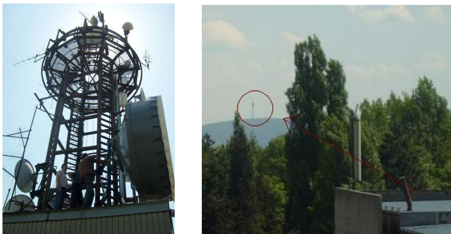
Slika 3.6. Parabolične reflektorske antene na Košutnjaku za veze sa emisionim centrima i pogled na jedan od njih – Avalu
